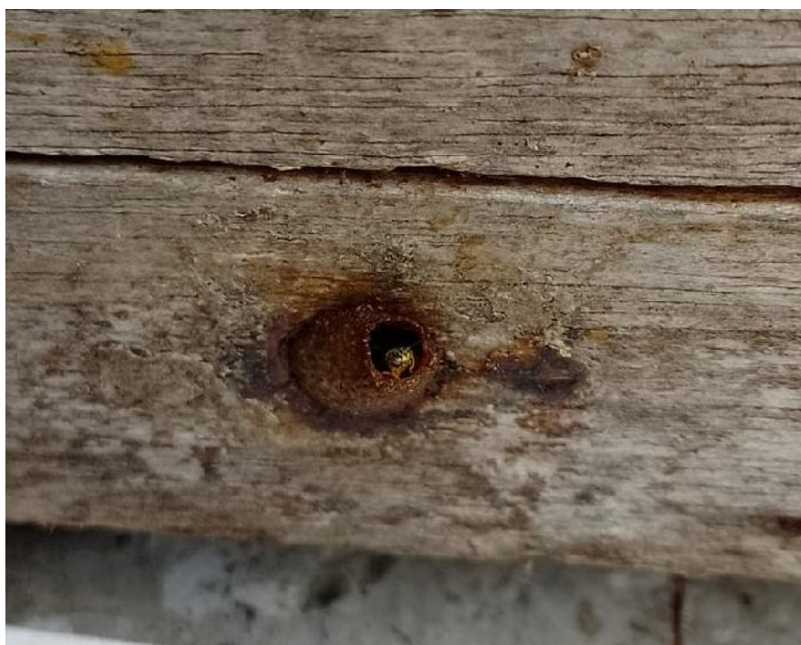
Figura 9. Opercular entrada y Construcción de escotilla
