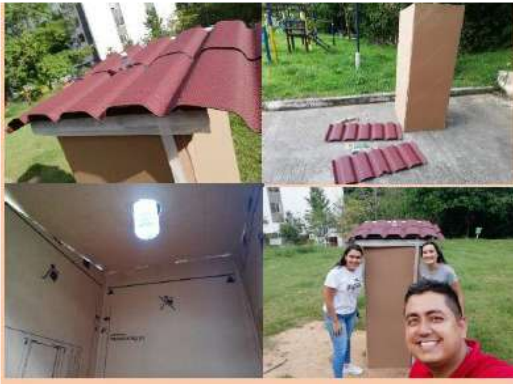
Figura 4. Sistema de iluminación con botellas solares.
